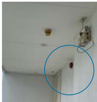
ภาพ 2-28 กริ่งสัญญาณเตือนภัย (Alarm Bell)
