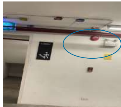
ภาพ 2-27 เครื่องตรวจจับความร้อน ( Heat Detector) และเครื่องตรวจจับควัน (Smoke Detector)
