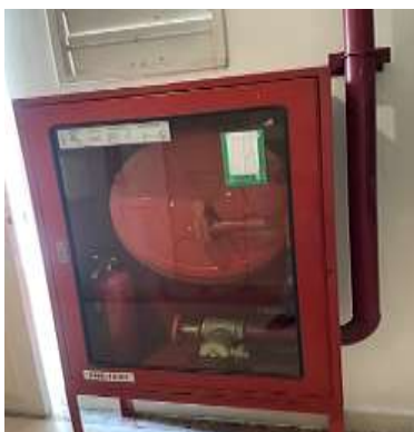
ภาพ 2-21 ตู้เก็บสายฉีดน้ำดับเพลิงพร้อมอุปกรณ์ (FHC) ติดตั้งถึงเคมีภายในตู้ และมีข้อความ / รูปภาพการใช้อุปกรณ์ดับเพลิง สะดวกในการใช้กรณีฉุกเฉิน
