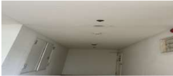
ภาพ 2-27 เครื่องตรวจจับความร้อน ( Heat Detector) และเครื่องตรวจจับควัน (Smoke Detector)
